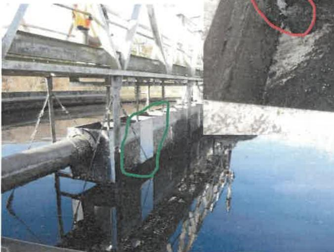
Réparation temporaire de la goulotte du clarificateur avec la mise en place d'une plaque.
